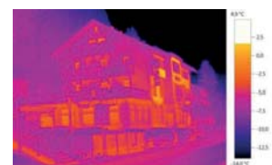
Immagine termica con testo ScaleAssist
