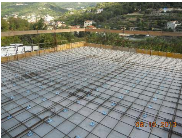
Figura 2. Rinforzo di solaio laterocementizio con connettori Tecnaria CTCEM. Dopo aver posato i connettori si dispone la rete, sovrapponendo correttamente i fogli.
