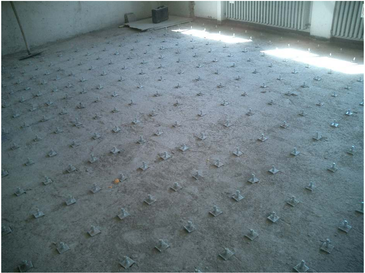
Figura 1. Rinforzo di solaio laterocementizio con connettori Tecnaria CTCEM. Fase di posa dei connettori
