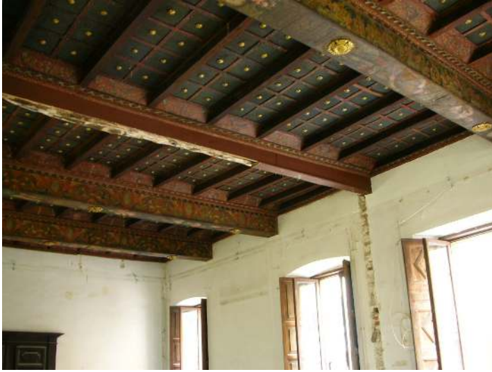
Figura 1 Tipico solaio a doppia orditura.
