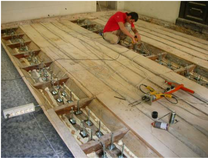
Figura 2. Connessione di trave principale con doppia fila di connettori. Si può notare il doppio trapano con supporto, uno strumento che permette di fare due prefori per l'applicazione del connettore Maxi in una unica operazione e potendo operare stando in piedi.
