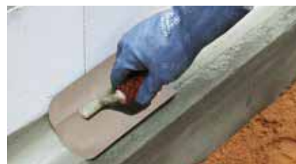
Realizzazione sguscia con MasterSeal 590
