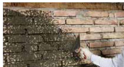
Realizzazione di rinzafo con additivo superadesivo
