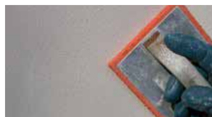
Frattazzatura della malta
