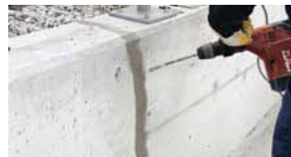
Esecuzione fori nei punti di iniezione
