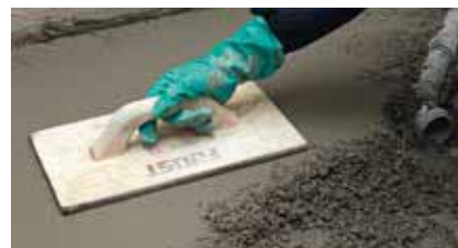
Applicazione della malta da ripristino
