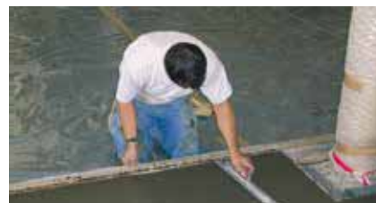
Realizzazione massetti con additivi superadesivi
