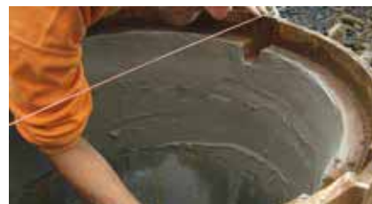
Allettamento telai, elementi prefabbricati
