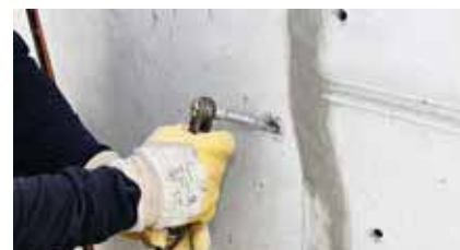
Inserimento tubicini/elementi di iniezione
