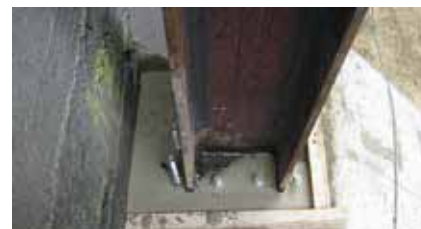
Esempio di colaggio sottopiastra
