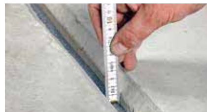
Verifica delle corrette dimensioni del giunto
