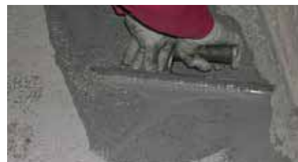
Applicazione della malta per riprese di getto
