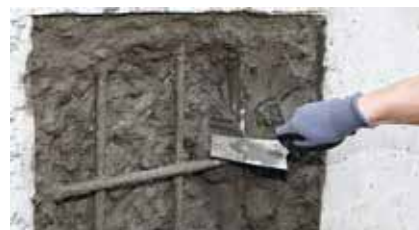
Applicazione a mano della malta da ripristino
