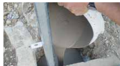
Esempio di colaggio di MasterFlow 960
