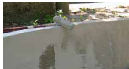
Applicazione del rivestimento impermeabilizzante a rullo
