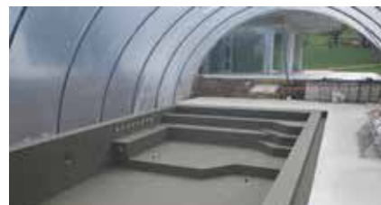
Rivestimento impermeabilizzante applicato
