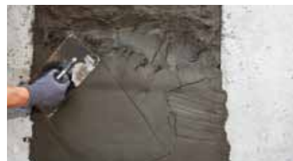
Applicazione a mano della malta da ripristino
