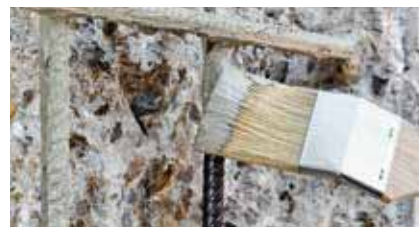
Passivazione delle armature
