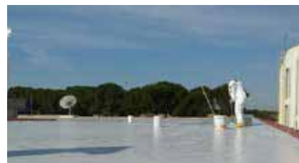
Applicazione dell'impermeabilizzazione
