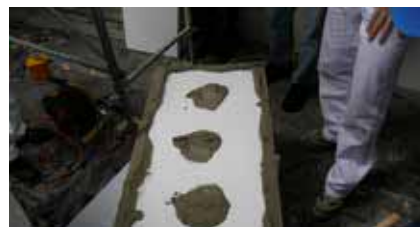
Applicazione di MasterEmaco ADH 290 come collante
