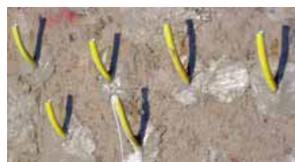
Completamento dell'iniezione con fuoriuscita della miscela
