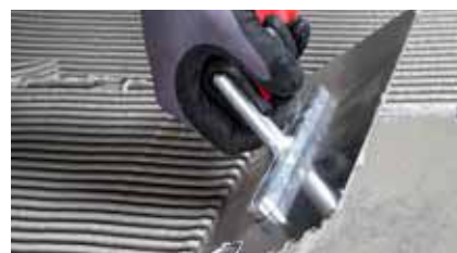
Applicazione con spatola dentata di MasterSeal 528
