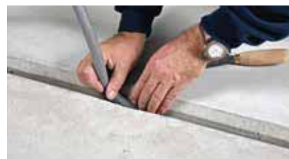
Applicazione del fondo giunto
