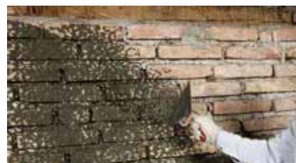
Applicazione del rinzafo (per supporti di qualità può essere utilizzato lo stesso intonaco deumidificante)
