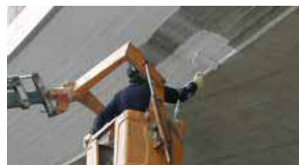
Applicazione a rullo della protezione
