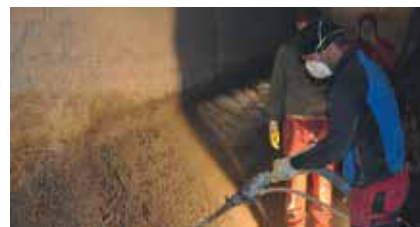
Applicazione a spruzzo della malta da ripristino
