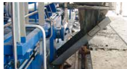
Applicazione della malta per ancoraggio
