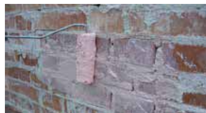
Applicazione di MasterEmaco P 110
