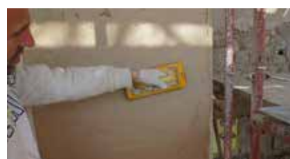
Frattazzatura della malta
