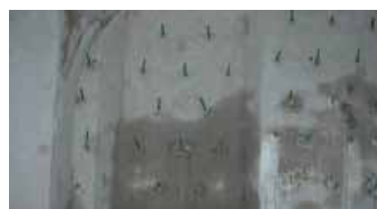
Completamento dell'iniezione
