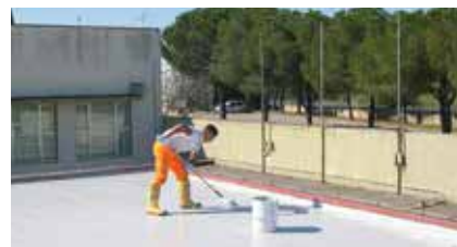
Applicazione dell'impermeabilizzazione
