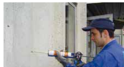
Esempio di applicazione di resina in cartuccia per inghisaggio di barre
