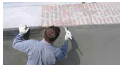
Applicazione del rivestimento impermeabilizzante a pennello
