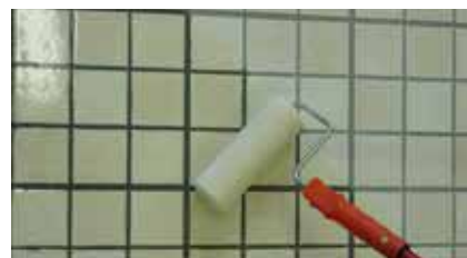
Applicazione a rullo dell'impermeabilizzante MasterSeal M 251
