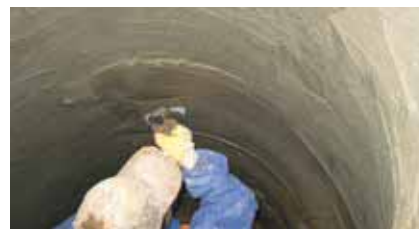
Ripristino e/o stuccatura con MasterEmaco S 5300
