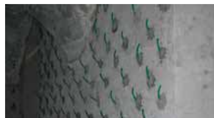
Preparazione dell'iniezione con stuccatura superfici e tubi di iniezione
