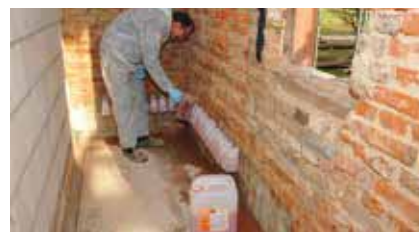
Pulizia e preparazione del supporto
