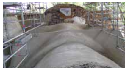
Esempio di applicazione su volte in muratura
