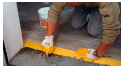
Realizzazione sottofondo/allettamento radido
