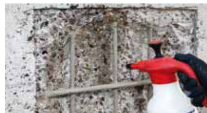
Saturazione del supporto
