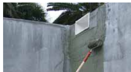
Applicazione del rivestimento impermeabilizzante
