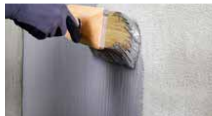
Applicazione a pennello dell'impermeabilizzazione
