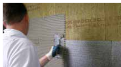
Applicazione di MasterEmaco ADH 290 come rasatura
