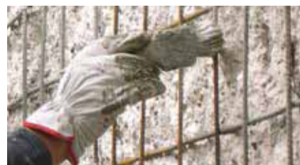
Passivazione delle armature
