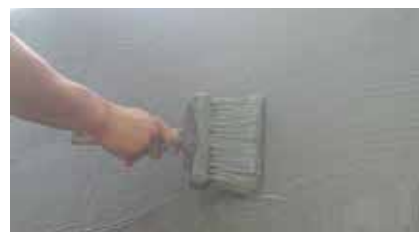
Applicazione a pennello dell'impermeabilizzazione
