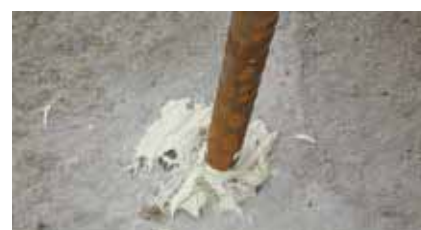
Inghisaggio di barre con resina in cartuccia
