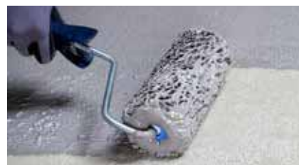
Applicazione a pennello di MasterSeal 528
