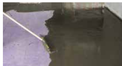
Applicazione della malta per riprese di getto
