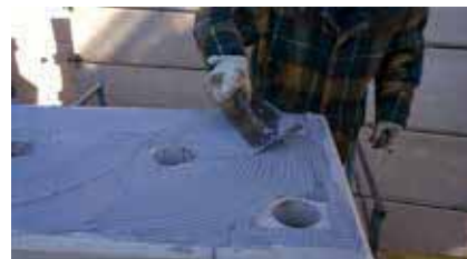
Applicazione dell'adesivo
