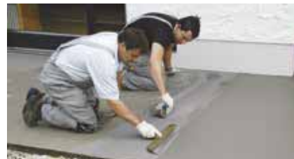
Applicazione dell'impermeabilizzante MasterSeal 528 sotto piastrella
