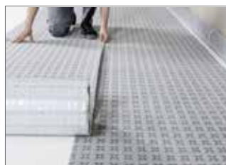
Sovrapposizione minima di 5 cm sul bordo longitudinale
