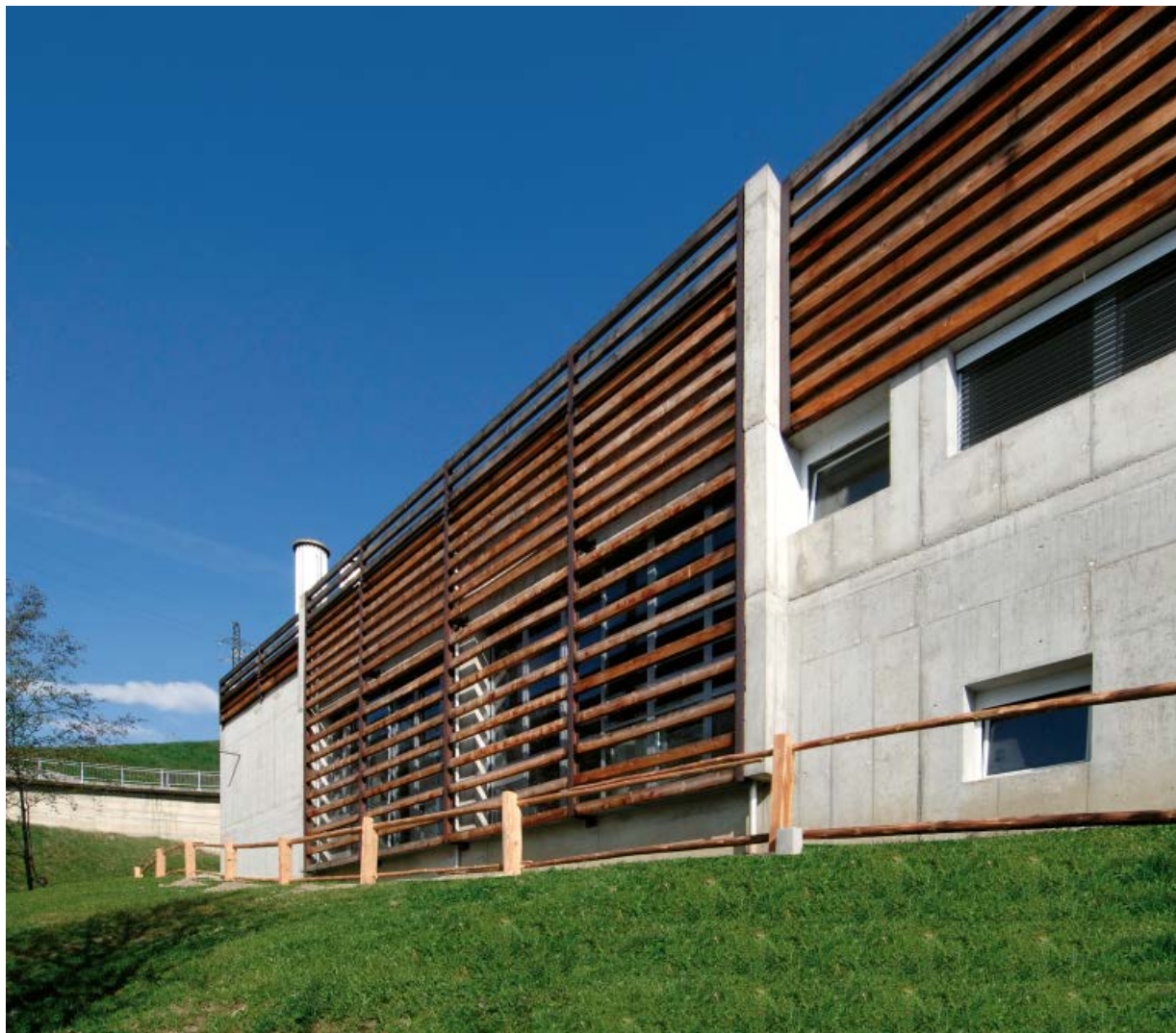
Impianto di teleriscaldamento a biomassa a Lazfons (BZ), Fonte SEL
