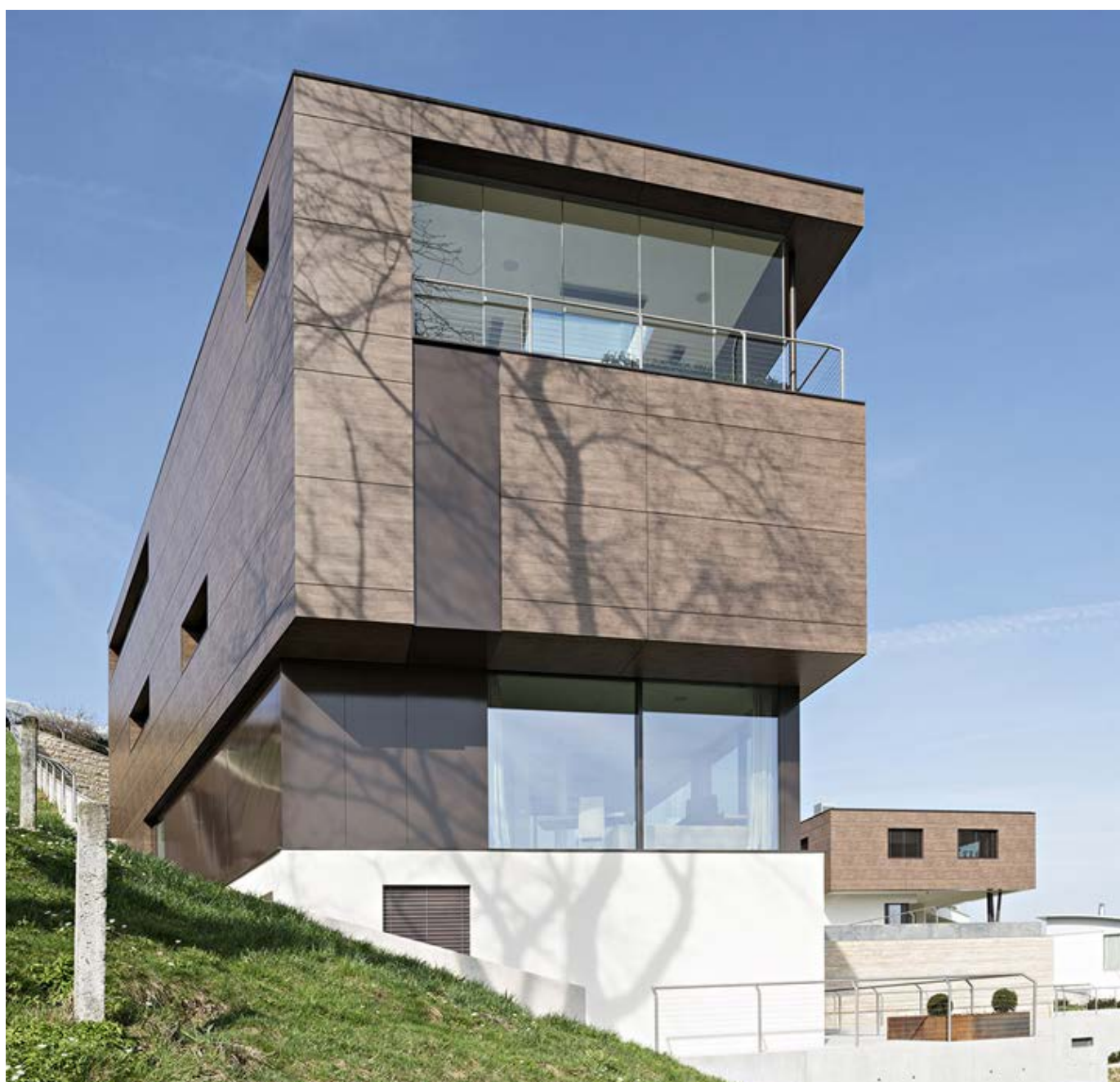
Edificio con facciate ventilate in Classe A
