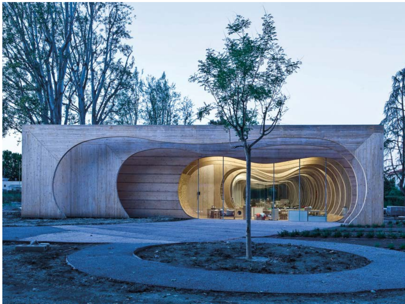
Asilo nido di Guastalla (RE) - Studio MCA
