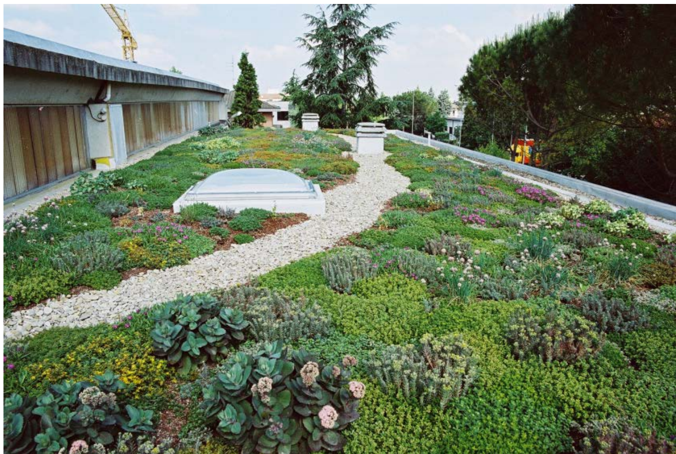
Tetto verde su copertura aziendale Co.Pa.Ri. a Forlì (FC), fonte DAKU Italia
