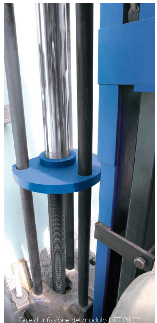
Fase di infissione del modulo LIFT PILE™
