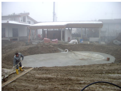
Fase 1: Realizzazione del fondo in cemento, sagomato e su livelli differenziati e montaggio pozzetto di fondo.
