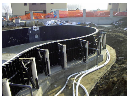
Fase 4: Installazione tubazioni. Si nota il particolare delle controventature ancorate con cemento.
