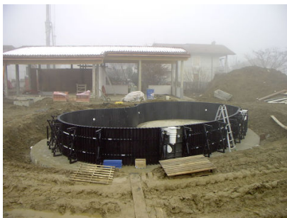
Fase 2: Montaggio dei pannelli su tutto il perimetro del fondo in cemento e montaggio accessori (bocchette e skimmer)
