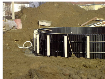
Fase 3: fissaggio e riempimento delle controventature. I tubi bianchi in PVC riempiti con tondini di ferro e cemento servono a sorreggere la pavimentazione perimetrale.
