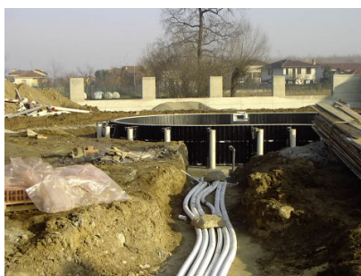
Fase 5: Reinterro struttura e tubazioni sotterranee.
