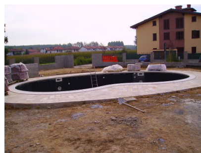
Fase 3: fissaggio e riempimento delle controventature. I tubi bianchi in PVC riempiti con tondini di ferro e cemento servono a sorreggere la pavimentazione perimetrale.
