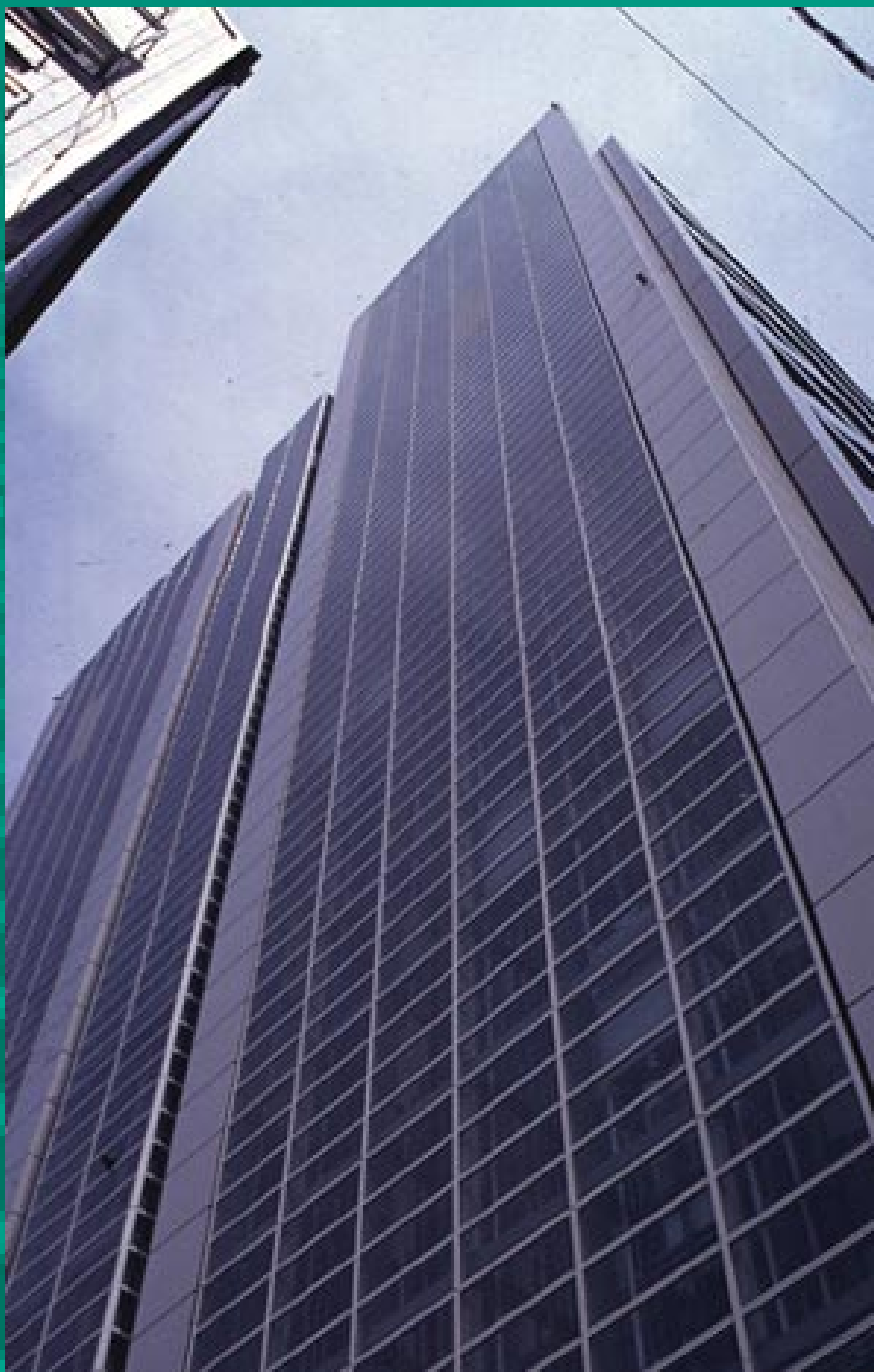
Norman Foster Associates, Century Tower , Tokyo, 1990. Scorcio del prospetto ovest. (Archivio LSA.2, foto A.C.).
