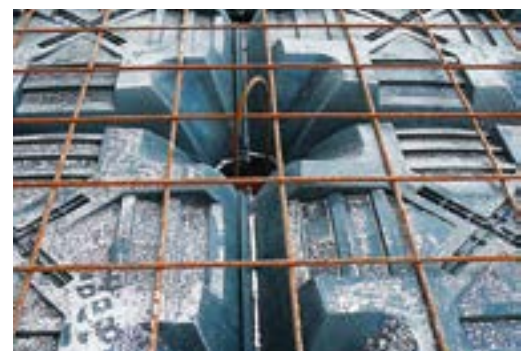
Rinforzo del pilastro con armatura
