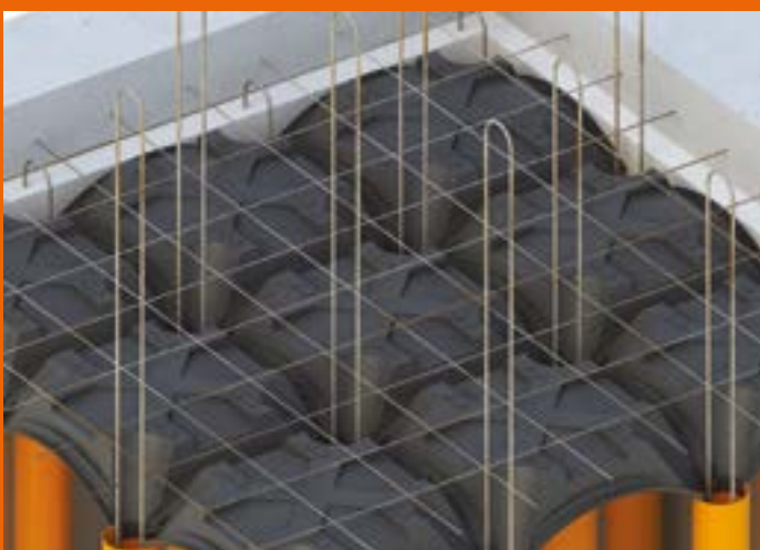
Posare la rete elettrosaldata e i ferri d'armo aggiuntivi nei pilastri.
