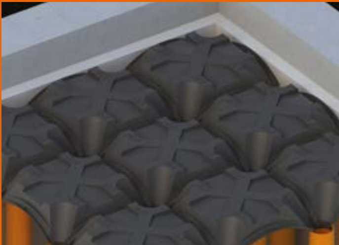
Posare i fermagetti a ridosso del cordolo.
