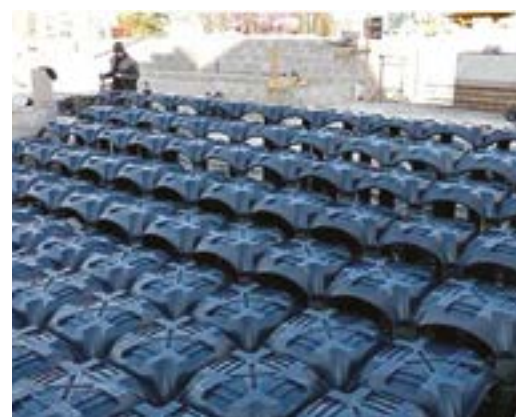
Dettaglio posizionamento casseri
