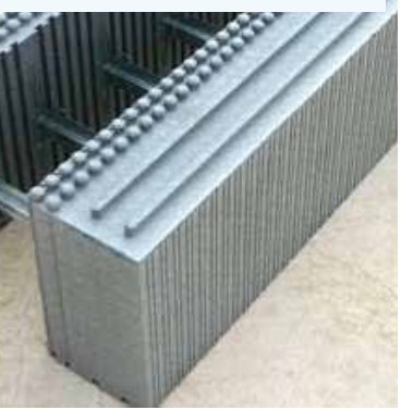
Particolare degli incastri e delle guarnizioni
