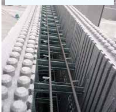
Particolare della coda di rondine interna e del distanziale
