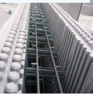
Particolare della coda di rondine interna e del distanziale
