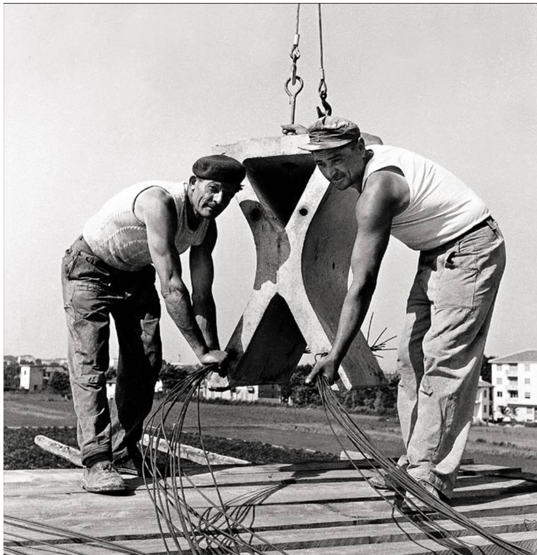
Angelo Mangiarotti, concio in cemento armato prefabbricato, in attesa dell'assemblaggio, Baranzate , 1956
