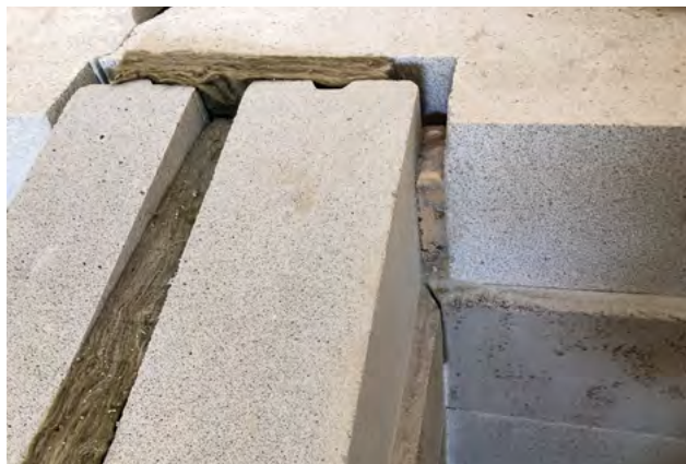
Esempio di nodo disaccoppiato tra divisorio acustico e parete esterna monostrato, con taglio dell'intonaco e sigillatura elastica.
