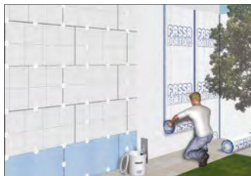
La sovrapposizione dei teli di rete, in senso orizzontale e verticale, dovrà essere di almeno 10 cm e di 15 cm in prossimità degli spigoli, precedentemente protetti con paraspigoli in PVC, rinforzando gli angoli delle aperture delle finestre con pezzi di rete oblique da circa 35 x 20 cm.
