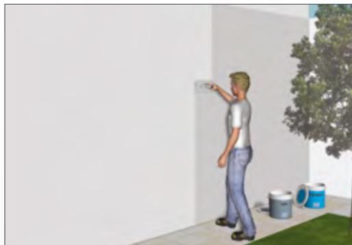
Si consiglia di utilizzare un rivestimenti di granulometria di almeno 1,5 mm e di un colore con un indice di luminosità Y > di 20.
