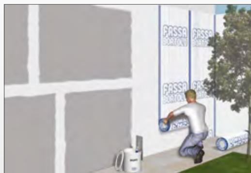
La presenza delle fasce azzurre laterali nella rete permette di identificare la corretta posizione di sormonto della stessa.
