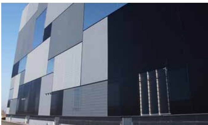
Montaggio indipendente dalla direzione dei pannelli Kalzip FC.
