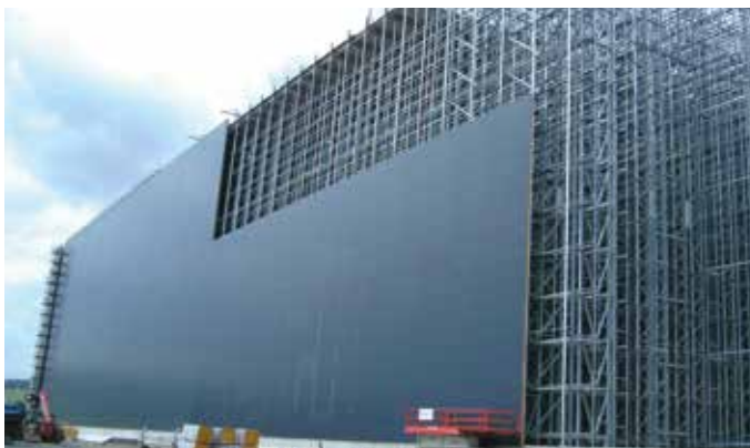
Montaggio veloce ed economico degli elementi sandwich FischerTHERM con guarnizione DUO.
