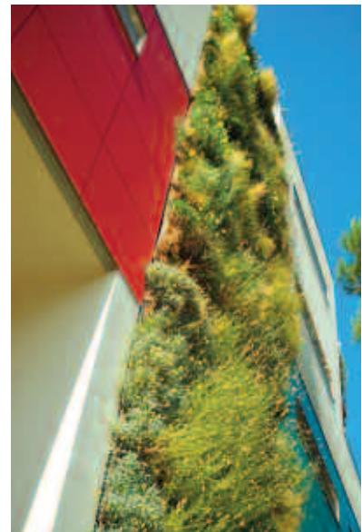
**Perliwall®** ha come elemento principale un materassino per il contenimento della perlite espansa (che svolge il compito di substrato di coltivazione ed accumulo idrico), formato da due strati di geotessile speciale cuciti in modo alternato sui due lati di una geogriglia monoaccoppiata a TNT, che creano degli scomparti a forma cilindrica ortogonali alla massima pendenza.
