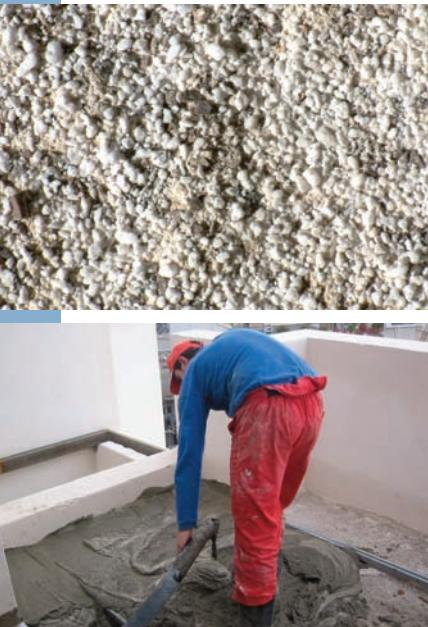
**Perlabeton®** è un **sottofondo alleggerito monostrato o massetto di finitura per sottofondi pluristrato**, ottenuto miscelando in opera il semi-premiscelato in polvere **Perlabeton S** - densità 500 kg/m<sup>3</sup> +/- 5% a caduta libera, costituito da perlite espansa di granulometria 1- 3 mm, sabbie selezionate di varia granulometria, additivi espandenti, fluidificanti, regolatori di presa - con cemento Portland 32,5 R o 42,5 R e acqua.
