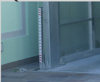
FOTOC. A BARRIERE COMPLETE DI LED DI SEGNALE PER CORRETTO POSIZIONAMENTO DELL'AUTO
