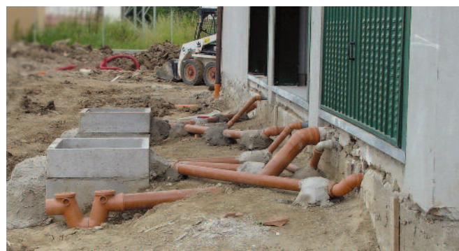
Esempio di installazione di sifoni AN all'esterno dell'abitazione
