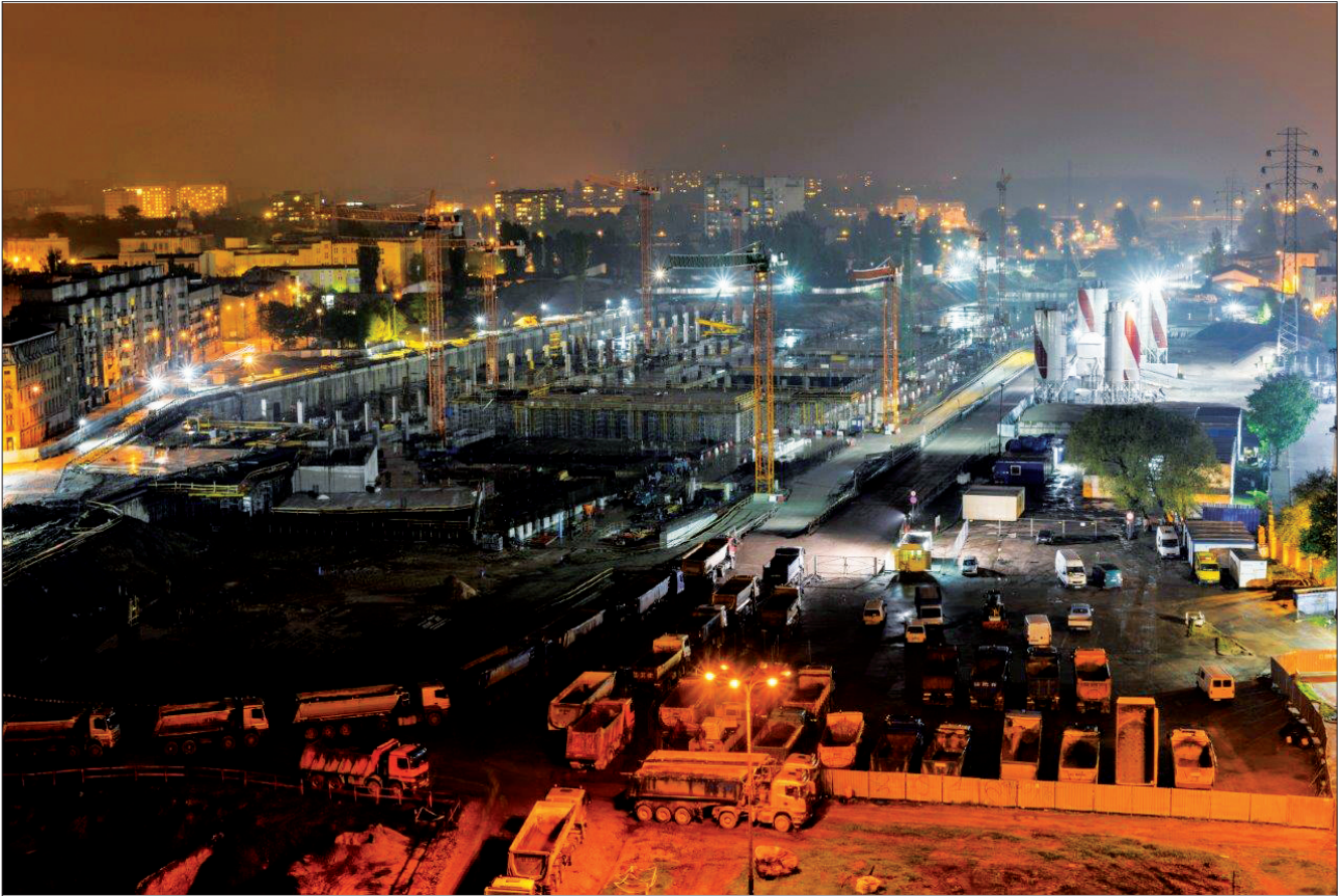
POLONIA, Astaldi, Stazione Ferroviaria di Lodz
