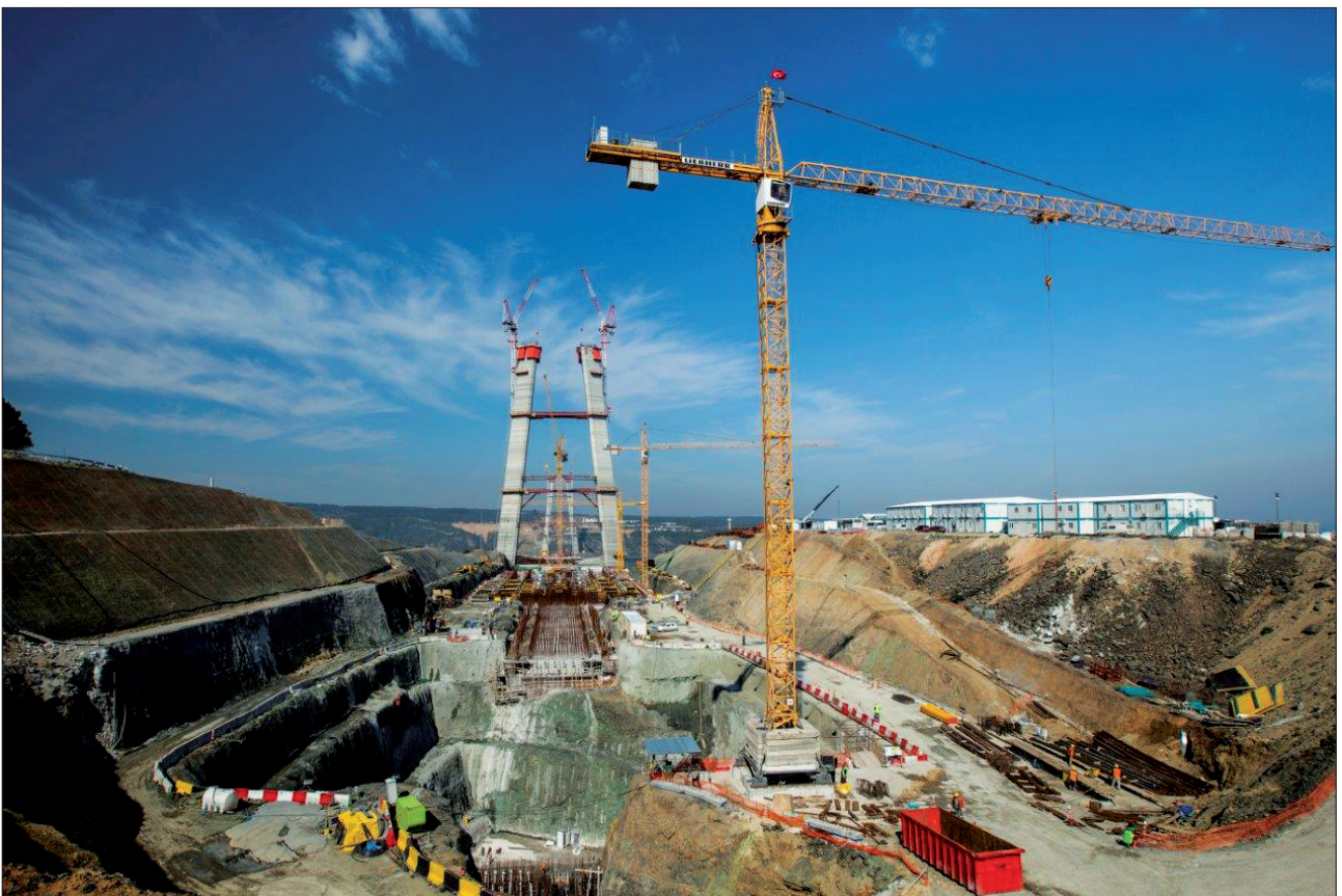
TURCHIA, Astaldi, Terzo Ponte sul Bosforo
