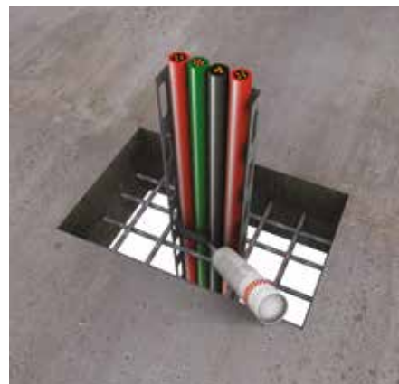
3. Applicare PROMASEAL®-AG per cavi e fasci di cavi
