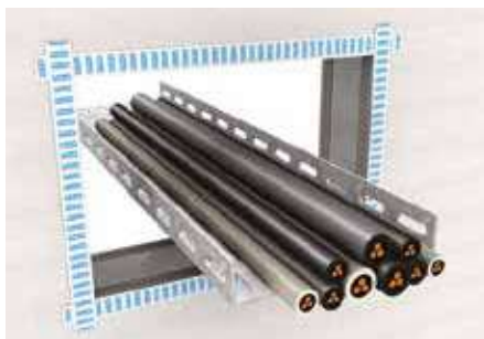
5. Se richiesto ricoprire il supporto con nastro adesivo di protezione
