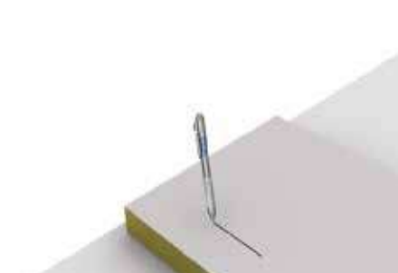
3. Trasferire le misure sul pannello in lana minerale
