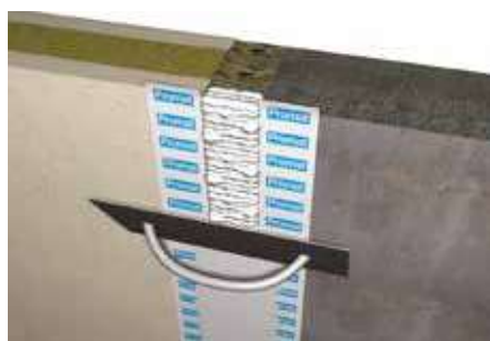
7. Stendere la superficie del sigillante prima della formazione della pellicola con un pennello o una spatola inumiditi con acqua
