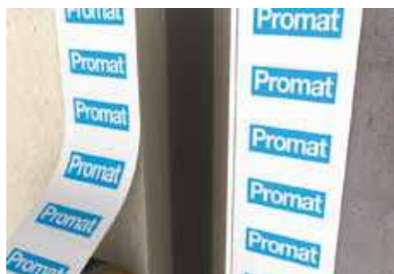
2. Se necessario, mascherare l'area di lavoro sulla parete/pavimento con del nastro
