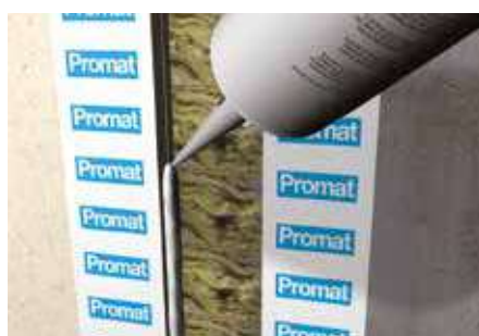
5. Assicurare una buona adesione tra il supporto e il primo strato di sigillante
