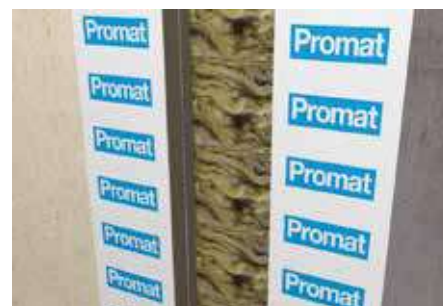
3. Riempire completamente il varco con materiale di riempimento (materiali incombustibili e combustibili)
