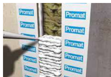
6. Applicare il corretto spessore di sigillante
