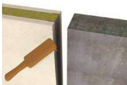
1. Pulire l'apertura e se necessario gli attraversamenti
