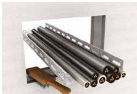
1. Pulire l'apertura dell'area di attraversamento
