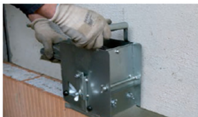
Applicazione della malta speciale con il rullo stendi malta
