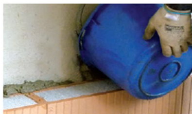
Riempimento dell'intercapedine con malta di allettamento
