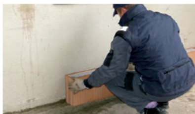
Applicazione del primo corso di Porotherm Revolution
