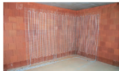
Porotherm Revolution fornisce un supporto ottimale per il montaggio di sistemi di riscaldamento a parete.
