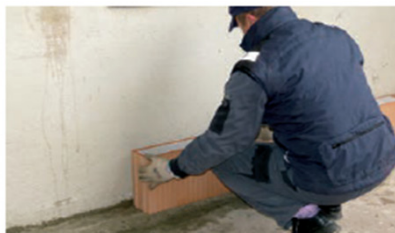
Applicazione del primo corso di Porotherm Revolution
