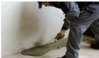
Realizzazione del piano di posa a livello per il primo corso di blocchi
