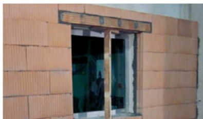
Completamento della parete isolata
