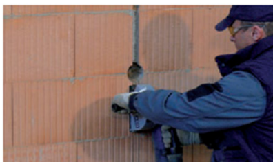
Realizzazione delle tracce con opportuno scanalatore
