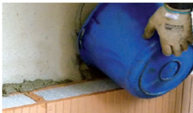
Riempimento dell'intercapedine con malta di allestimento
