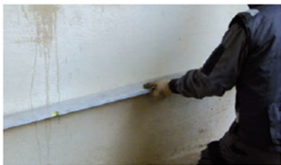
Controllo della superficie: planarità, verifica dell'aderenza dell'intonaco, ecc.
