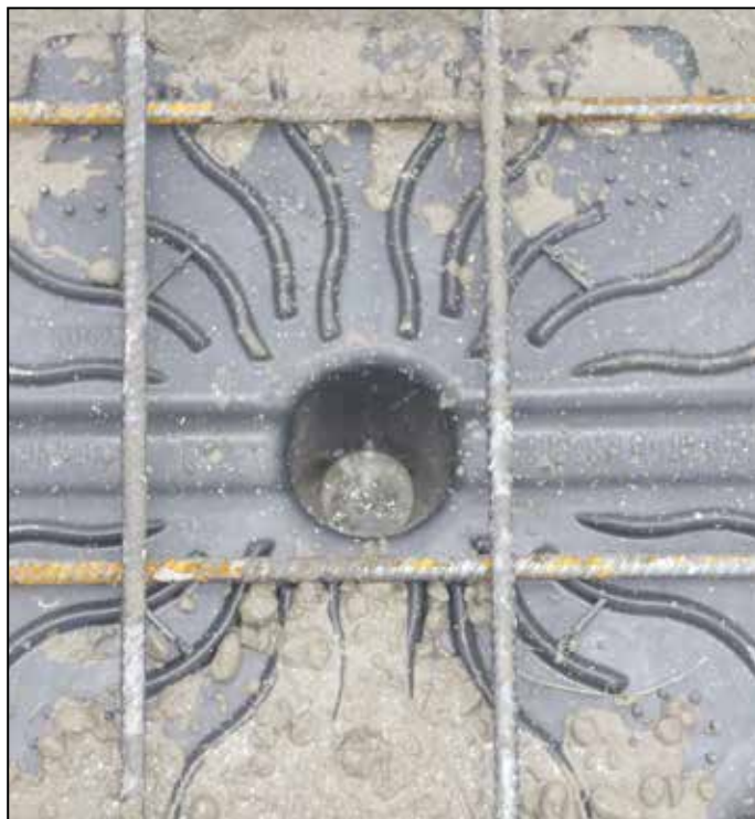
Controllo visivo dell'effettivo completamento della soletta inferiore
