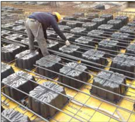
④ COMPLETAMENTO POSA ARMATURA
