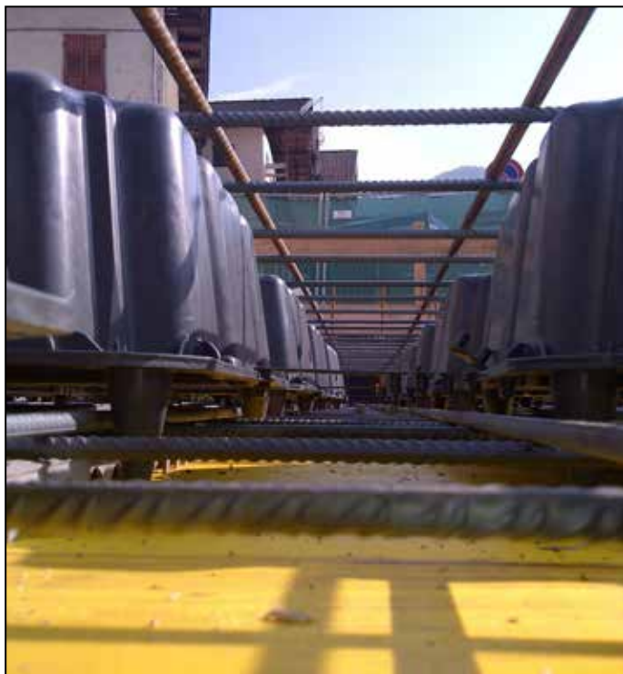
Utilità dei piedini inferiori per la creazione della soletta inferiore
