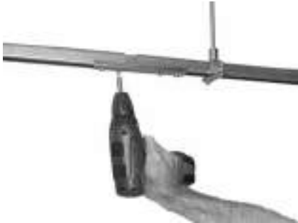
Figura 69. Fissare il successivo binario al connettore e stringere le 4 viti.
