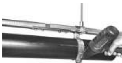
Figura 74. Innestare la parte anteriore del bracciale nel gancio e stringere la vite.
