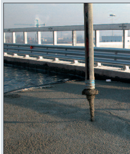
Pompaggio calcestruzzo da centrale di betonaggio.
