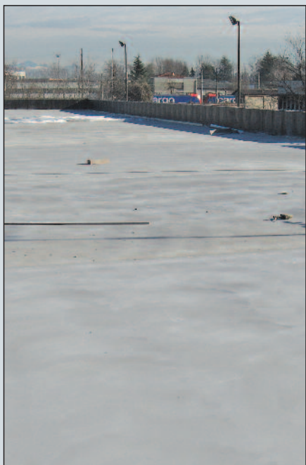
Pavimento industriale in copertura carrabile.
