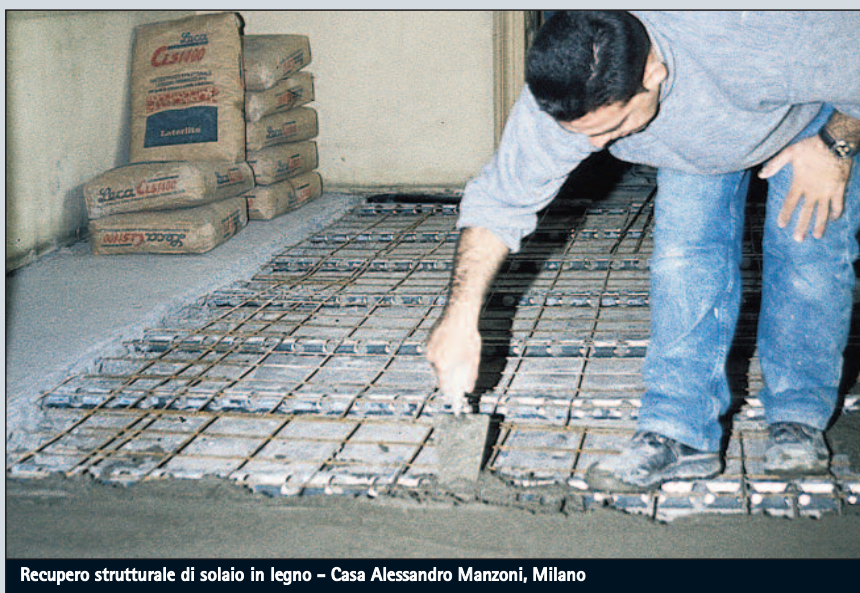
Consolidamento: connessione a pioli
