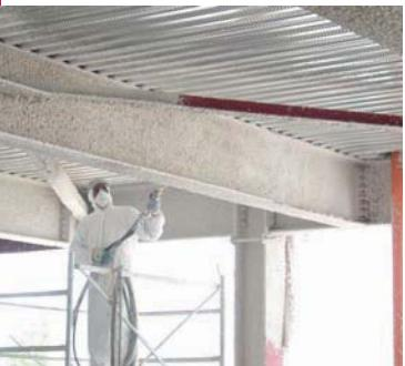
**Mandolite CP2** è un intonaco premiscelato a base di vermiculite espansa e cemento Portland, da utilizzare in ambienti interni e/o protetti; viene applicato a spruzzo con macchine intonacatrici.
