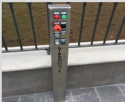
PULSANTIERA DI COMANDO COMPLETA DI SEGNALE LUMINOSE PER INDICARE LO STATO DEL MONTAUTO
