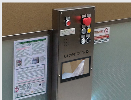
PULSANTIERA A BORDO PIATTAFORMA COMPLETA DI MONITOR DI SORVEGLIANZA
