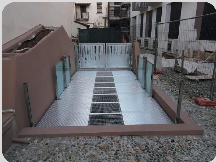
PIANALI GRIGLIATI PER CONSENTIRE L'AREAZIONE ALL'INTERNO DEL VANO CORSA
