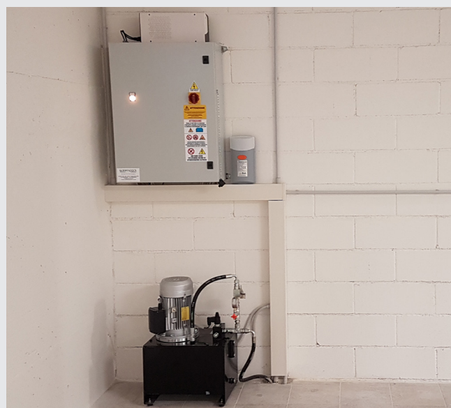
QUADRO MACCHINA E CENTRALE IDRAULICA
