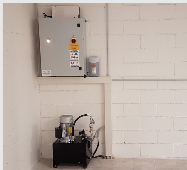
QUADRO MACCHINA E CENTRALE IDRAULICA
