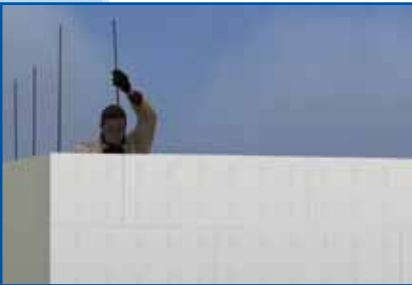
INSERIMENTO ARMATURE
