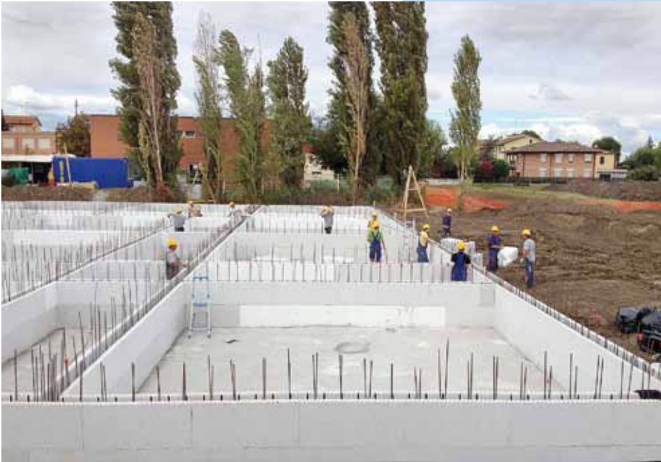
INSERIMENTO ARMATURE
