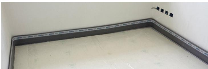
FLEXO viene fornito in rotoli di altezza 20 cm e lunghezza 25 m da applicare prima del manto anticalpestio, fissando la fascia grigia adesiva alla muratura in elevazione e la fascia bianca in orizzontale, senza tralasciare le soglie delle entrate e delle porte-finestre.
