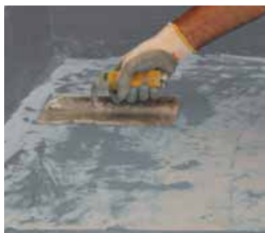
Impermeabilizzazione di una terrazza. Posa di rete di rinforzo dopo la stesura della prima mano di FLEXO e di nastro impermeabile in corrispondenza di spigoli e di giunzioni tra piani orizzontali e verticali.
