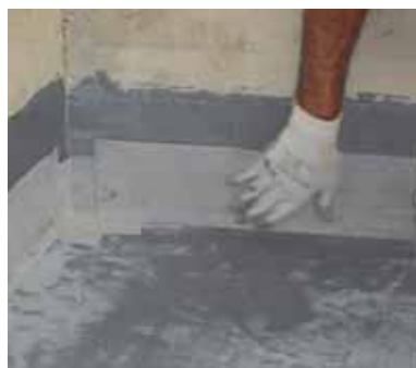
Impermeabilizzazione di una terrazza. Posa di rete di rinforzo dopo la stesura della prima mano di FLEXO e di nastro impermeabile in corrispondenza di spigoli e di giunzioni tra piani orizzontali e verticali.
