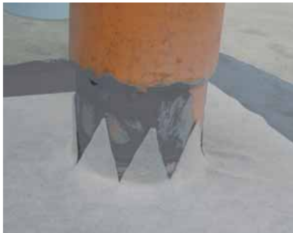
Impermeabilizzazione di una terrazza con presenza di un pluviale: preparazione e posa di nastro impermeabile in tessuto non tessuto
