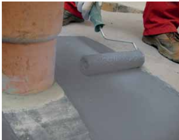
Impermeabilizzazione di una terrazza con presenza di un pluviale: preparazione e posa di nastro impermeabile in tessuto non tessuto
