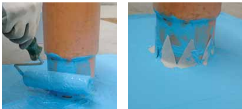
Impermeabilizzazione di una terrazza. In presenza del pluviale, è stato posato un nastro impermeabile in tessuto non tessuto.
