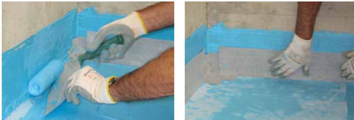
Stesura di FLEXO LIQUID per impermeabilizzazione di un balcone, dopo aver posato il nastro impermeabile in tessuto non tessuto in concomitanza della giunzione tra piano orizzontale e verticale.
