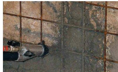
L'intervento di ristrutturazione si completa con un ciclo di intonacatura e finitura o, in alternativa, con la rasatura fibrorinforzata GEOACTIVE FINE B 543; per limitare il potenziale evidenziarsi di microcavillature si consiglia di inserire una rete in fibra di vetro all'interno della finitura o della rasatura.
