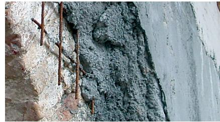
Eventuali ripristini di parti in calcestruzzo dove non si necessitino elevati spessori (granulometria < 0,6 mm) ed elevate caratteristiche prestazionali (20 MPa, la resistenza a compressione a 28 gg) come ad esempio per il ripristino di parti di marciapiedi o cornicioni ecc. si utilizzerà il prodotto: "RENOVA BR 575" malta fibrorinforzata, tixotropica, rapida con possibilità di finitura a civile.
