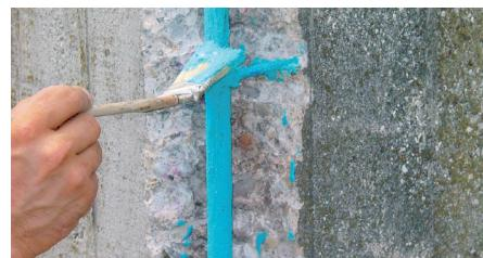
A saturazione del fondo avvenuta, in assenza di ristagno d'acqua liquida, l'intervento prevede l'applicazione della malta ad elevate caratteristiche prestazionali: "GEOACTIVE TOP B 525" malta solfatoresistente, fibrorinforzata, tixotropica a ritiro controllato per il ripristino del calcestruzzo, avendo cura di interporre, dove necessario, un'apposita rete eletrosaldata che deve essere preventivamente fissata al supporto.
