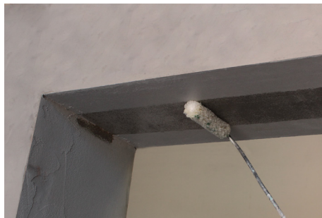
Fase 2: Trattamento con FASSA EPOXY 100, ove necessario
