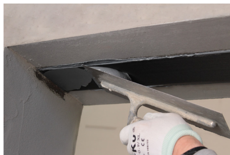
Fase 8: Applicazione di FASSA EPOXY 400 sulla lamina
