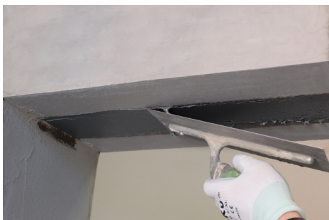
Fase 3: Regolarizzazione con FASSA EPOXY 400
