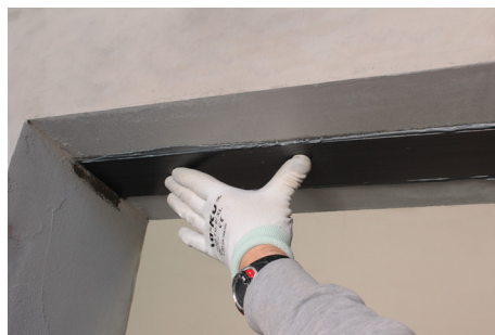
Fase 6: Posizionamento di FASSAPLATE CARBON
