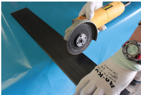
Fase 1: Taglio della lamina FASSAPLATE CARBON S/HM/HHM
