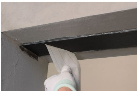
Fase 7: Rimozione della seconda pellicola protettiva
