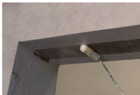
Fase 2: Trattamento con FASSA EPOXY 100, ove necessario
