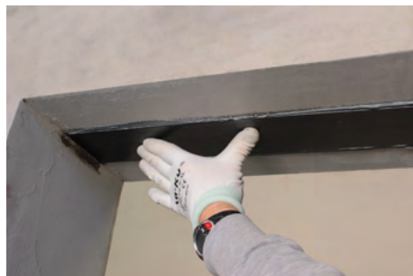
Fase 6: Posizionamento di FASSAPLATE CARBON
