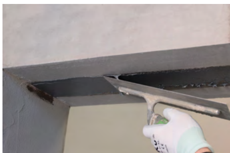
Fase 3: Regularizzazione con FASSA EPOXY 400
