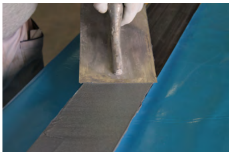
Fase 5: Applicazione di FASSA EPOXY 400 sulla lamina
