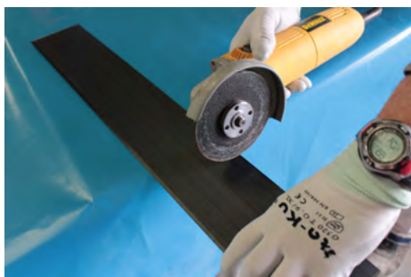
Fase 1: Taglio della lamina FASSAPLATE CARBON S / HM / HHM
