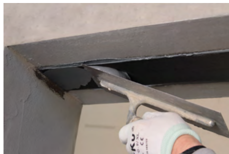
Fase 8: Applicazione di FASSA EPOXY 400 sulla lamina
