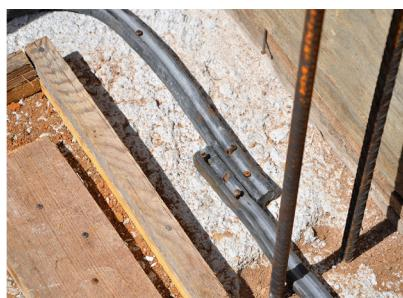
Predisporre i casseri per il getto in elevazione, avendo cura di posizionare le lame o distanziatori ad una quota di almeno 10 cm dalla superficie di posa di AQUAZIP JOINT e garantendo un confinamento laterale del cordolo di almeno 8 cm.
