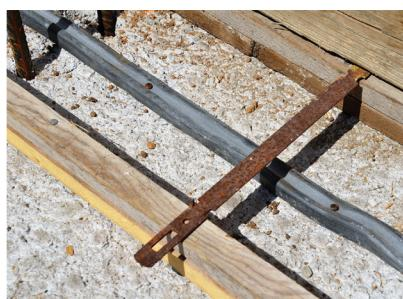
Evitare durante la posa di AQUAZIP JOINT qualsiasi situazione che possa generare uno schiacciamento del giunto bentonitico o impedisca il suo regolare confinamento da parte del getto di calcestruzzo.
