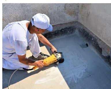
**Si sconsiglia di eseguire cicli di idrolavaggio della vecchia pavimentazione in quanto tale operazione favorisce l'apporto di ulteriori quantità di acqua nel supporto sottostante.**
