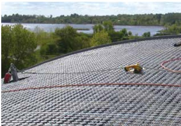
DRAINROOF studiato, appositamente per le coperture, garantisce la massima semplicità di posa. Il sistema di aggancio fissa tra loro i pannelli, evitando sollevamenti e spostamenti; la struttura a cupole in materiale plastico evita qualsiasi
