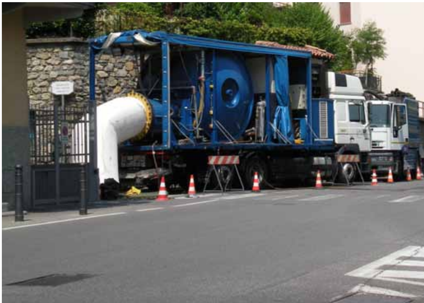
Relining CIPP con posa ad inversione ad aria di un collettore diametro 100 cm direttamente da un chiusino standard.
