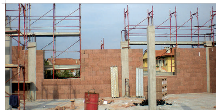
■ Esempi di cantieri realizzati con il metodo della tamponatura in Legnobloc su telaio a travi e pilastri.
