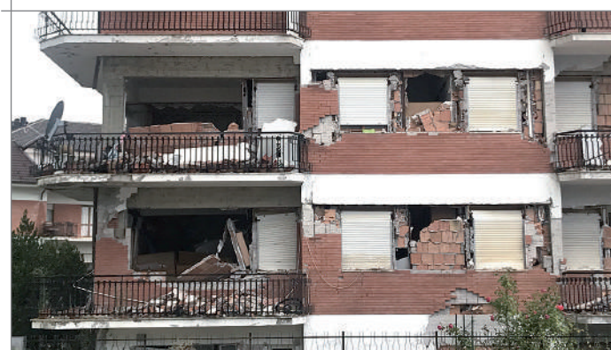
■ Cedimento pareti in appoggio a pilastri in un vecchio edificio con struttura a telaio, in seguito al sisma del 2009 all'Aquila.
