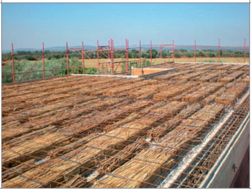
■ Esempio di posa in opera di un SOLAIO SOLAFON con isolamento ecologico a pignatta in CANNA PALUSTRE (super ecologico e super performante).
