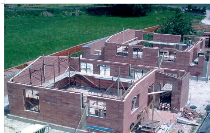
■ Abitazioni in costruzione con sistema costruttivo Legnobloc in seguito al sisma del 2009 all'Aquila.
