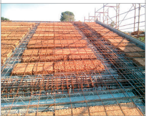
■ Esempio di posa in opera di un SOLAIO SOLAFON DI COPERTURA con isolamento ecologico a pignatta in SUGHERO (super ecologico e super performante).
