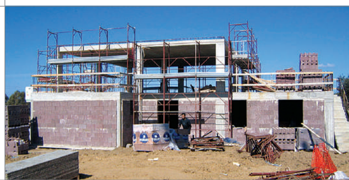
■ Esempi di cantieri realizzati con il metodo della tamponatura in Legnobloc su telaio a travi e pilastri.
