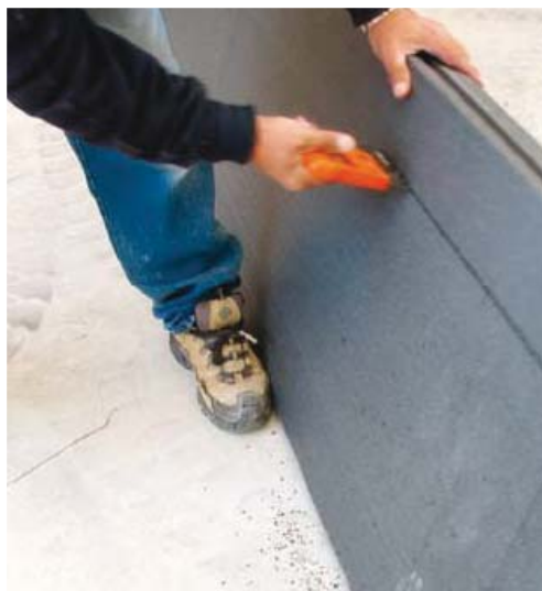
3 Taglio del pannello in corrispondenza del profilo metallico
