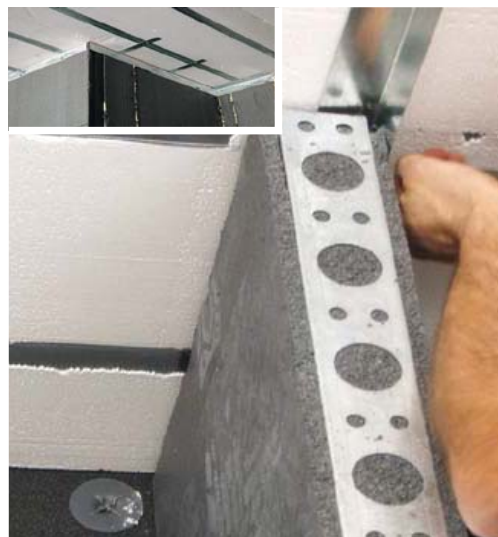
4 Avvitatura tramezza al profilo
