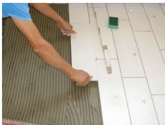
4. Posa della pavimentazione ceramica a finire
