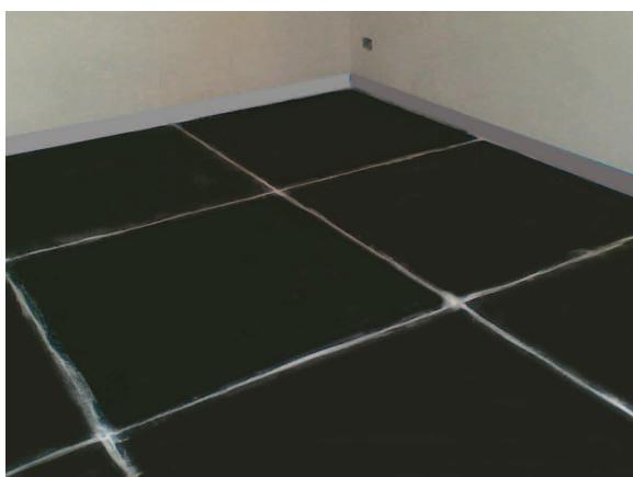
3. Materassino dBred posato in maniera continua con fasce perimetrali serie AD
