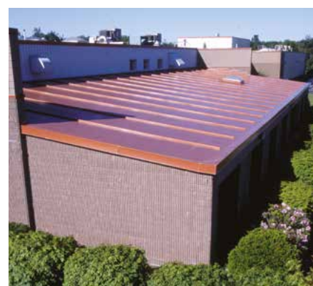
Coperture ad elevata valenza estetica
