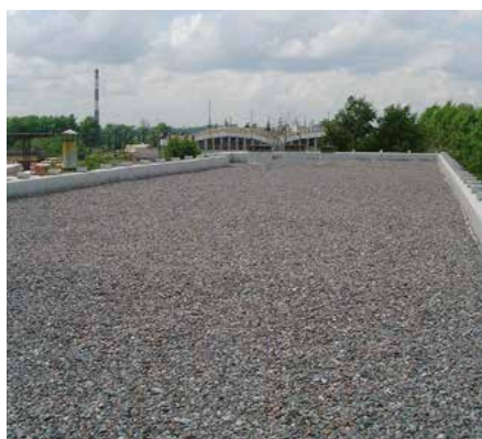
Coperture zavorrate ghiaia
