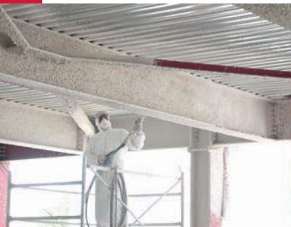
**CAFCO 300** è il prodotto più avanzato della ricerca **CAFCO**, a base di vermiculite espansa e leganti idraulici, da utilizzare in ambienti interni ed applicare a spruzzo con normali macchine intonacatrici.
