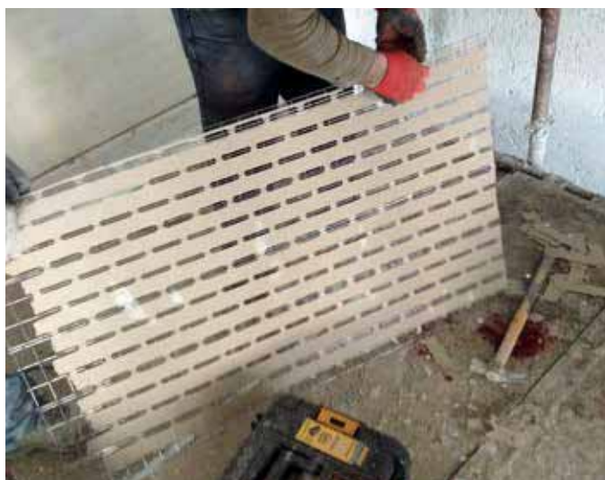
(1) Eventuale taglio a misura e preparazione del pannello Stucanet® S
