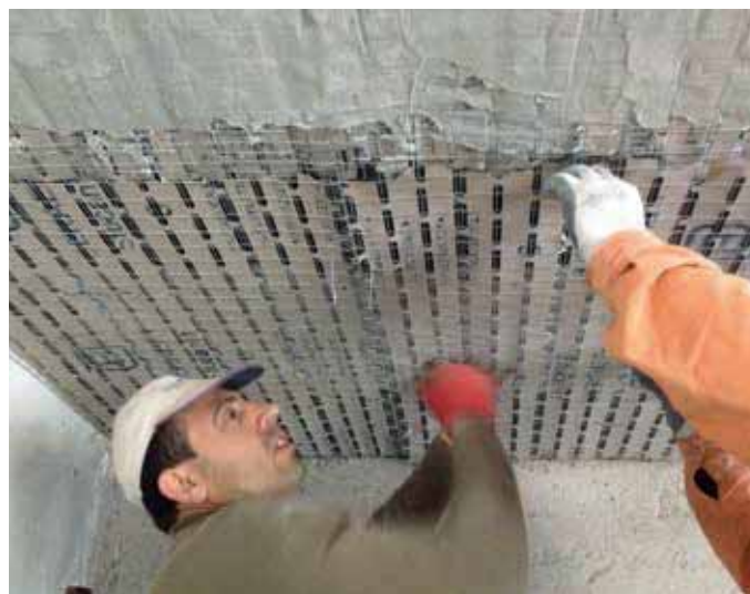
(2) Posizionamento del pannello Stucanet® S
