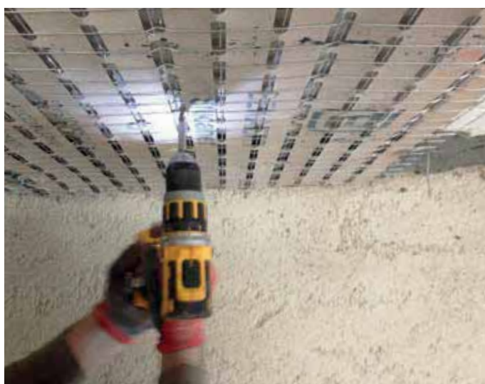
(5) Avvitamento del tassello meccanico per il fissaggio del pannello Stucanet® S
