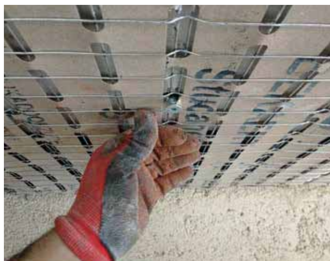
(4) Posizionamento del tassello meccanico per il fissaggio del pannello Stucanet® S
