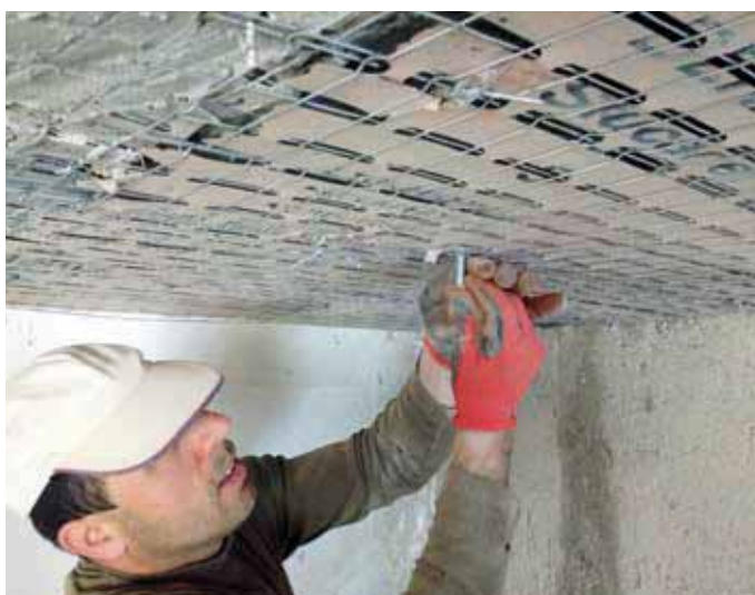
(3) Tracciamento ed esecuzione del foro per il fissaggio, con tassello meccanico, del pannello Stucanet® S
