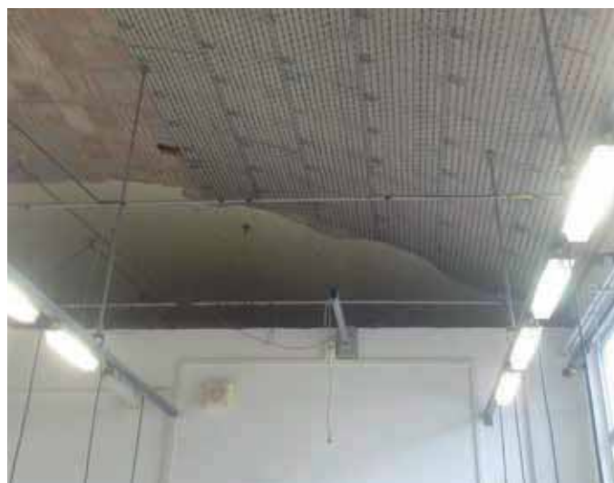
Fase di posa del sistema X Plaster W-System™
