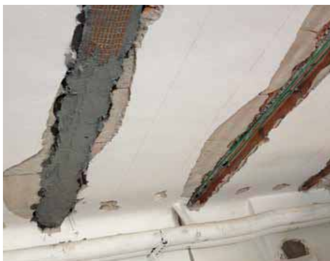
Esempio di solaio con ferri esposti e passivati con Rurecoat 3, travetto con rinforzo FRCM Ruregold XS Calcestruzzo e matrice Ruregold MX Calcestruzzo.
