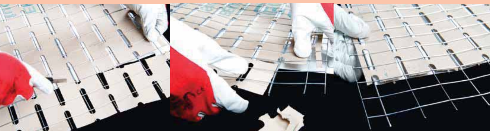
(1) Eventuale taglio a misura e preparazione del pannello Stucanet® S
