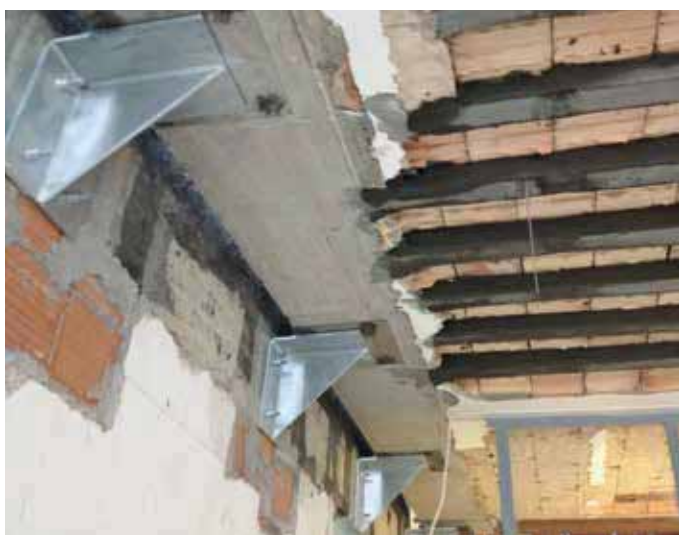
Esempio di solaio con fondello rimosso e ricostruzione volumetrica del travetto con malta Exocem PVA-TX.
