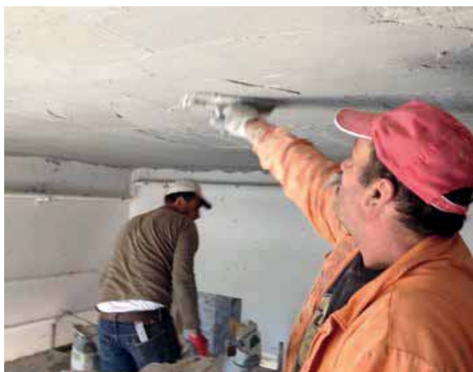
(6) Stesa della seconda mano della malta Plasterwall
