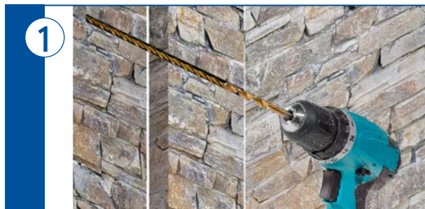
1 Preforo "guida" per successivo inserimento barra elicoidale.
